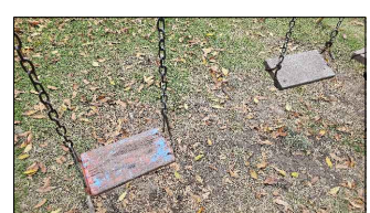
JUEGO A REPARAR ASIENTOS Y SISTEMA DE SUJECIÓN
