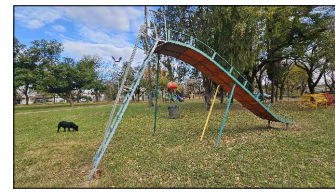
JUEGO A REPARAR CHAPA DE DESLIZAMIENTO EN SECTOR SUPERIOR
