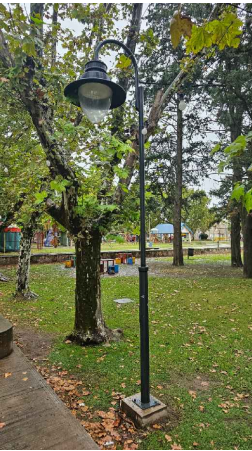
COLUMNA Y LUMINARIA DE REEMPLAZO, CON ARTEFACTO BORA Ó SIMILAR (20 u)
